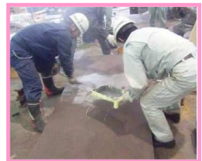
2次接着剤塗布 摩擦素子粒子散布・転圧
